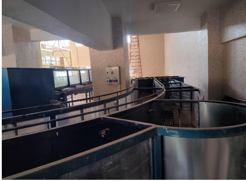
Şekil 13. Kıvrımlı kanaldan görünüm
